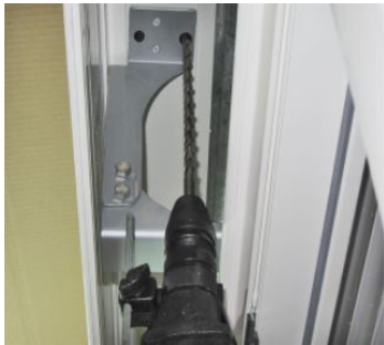
Löcher durch Konsole in Decke/Sturz bohren.
