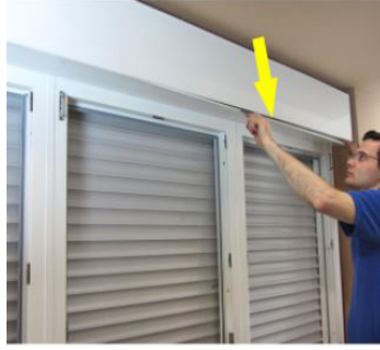
Revisionsdeckel öffnen.
