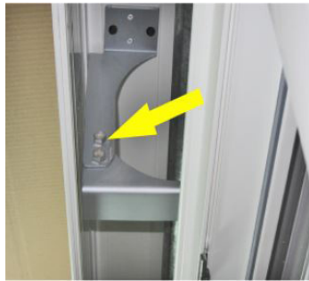
Konsole miteinander verschrauben.
