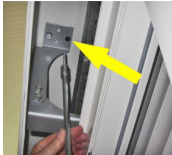
Statikkonsole mit geeigneten Schlüsselschrauben befestigen.
