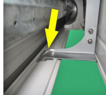
Statikkonsole auf Basisbrett mit beiliegendem Butylpad abdichten.
