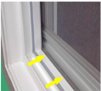
Bürstendichtung der Zugschiene muss innen dicht am Blendrahmen liegen.
