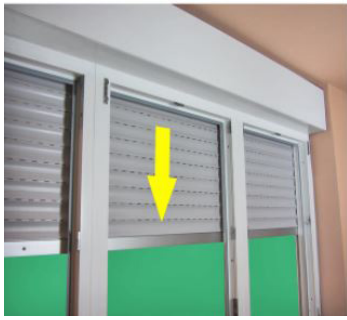
Rollladenpanzer an fertig montiertem Element schließen.
