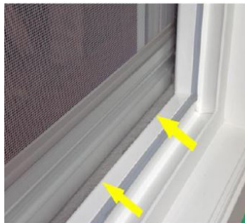
Bürstendichtung muss dicht anliegen und ISS-Gaze muss gleichmäßig gespannt sein.
