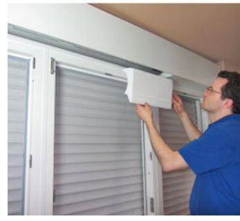
Dämmung und Dämmstück aus Rollladenkasten entnehmen.
