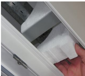
Dämmstück in Statikkonsole einsetzen.
