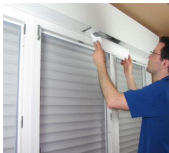
Dämmung einsetzen und Rollladenkasten schließen.
