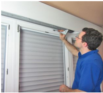
Untere Statikkonsole durch Basisbrett in Spezialverstärkungseisen einrasten.
